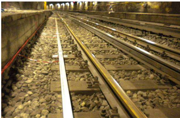
MyOtr – Monitoraggio binario misure sghembo e deformazioni longitudinali
