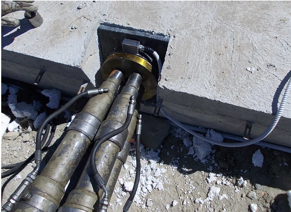
Fig. 2 – Cella di carico – fase di tesatura tirante
