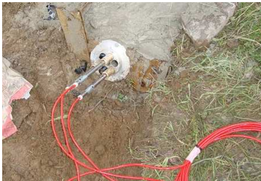
Fig. 4 – Estensimetro Multibase – Particolare installazione trasduttori di spostamento
