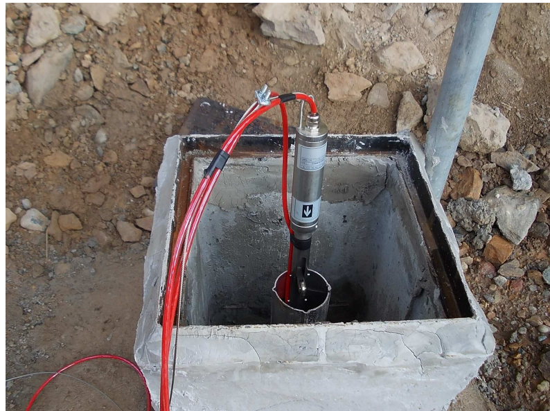
Fig. 4 – Installazione Sonda inclinometrica fissa di profondità
