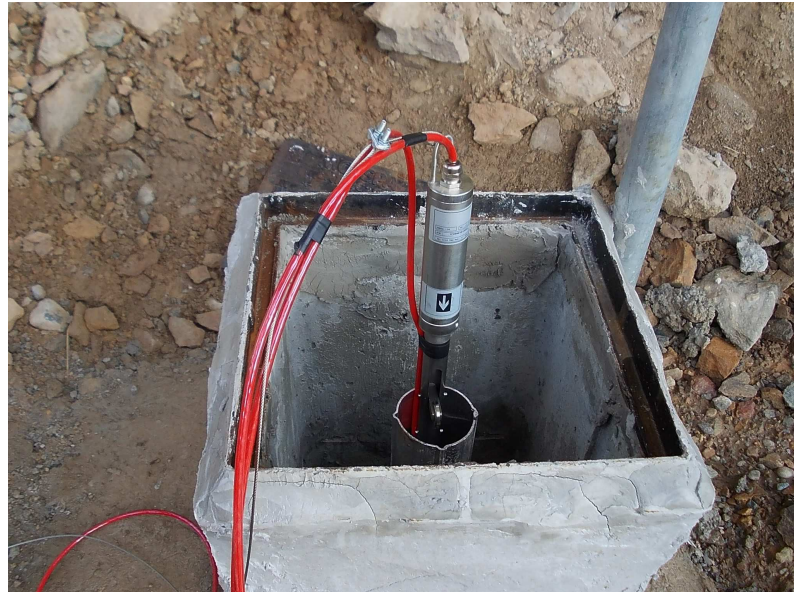
Fig. 4 – Installazione Sonda inclinometrica fissa di profondità
